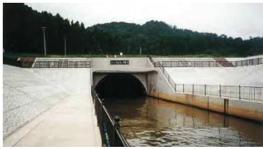
新々樋曾山隧道
