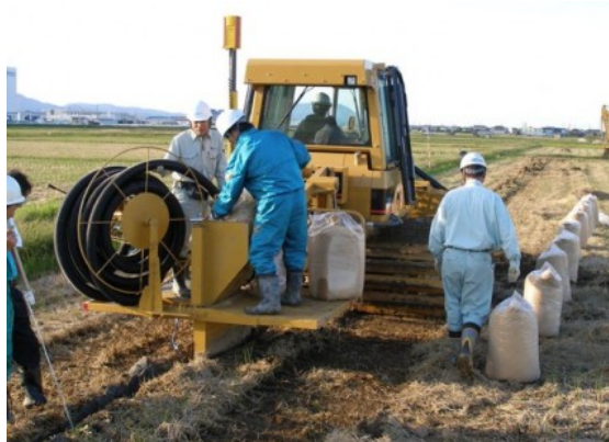
ベストドレーン機での自動埋設
